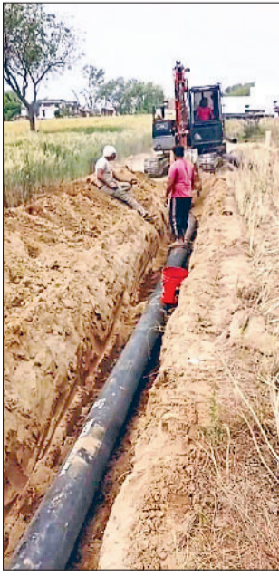
महेंद्रगढ़। प्रोजेक्ट के लिए बिछाई जा रही पाइप लाइन व गांव नंगला में खोदा गया जोहड़।
